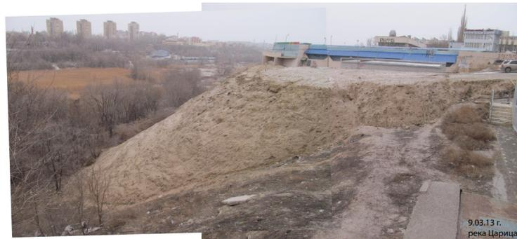
Рисунок 4.8 - Засыпка левого склона долины реки Царицы (9.03.2013)
