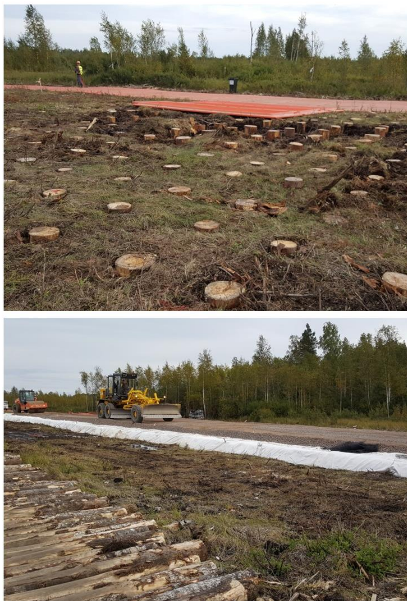
Рисунок 5.2 – Строительство временной подъездной дороги из деревянных свай (осень 2018 г.)
