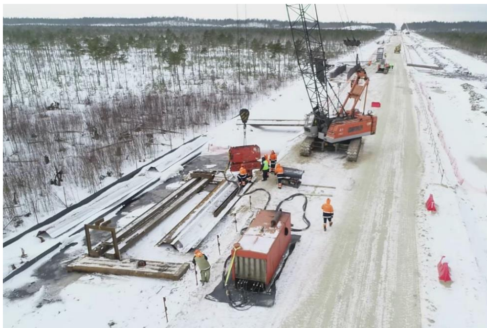
Рисунок 5.3 – Процесс строительных работ (вид на юго-запад), зима 2018–2019 г.
