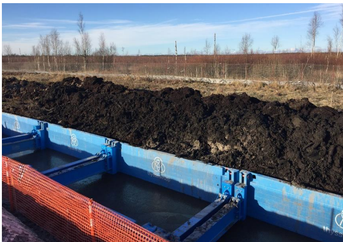
Рисунок 5.6 – Установка траншейных крепей (октябрь 2018 г. – март 2019 г.)
