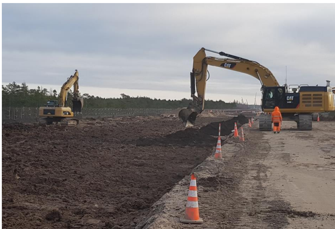
Рисунок 5.9 – Укладка торфа в строительном коридоре (осень 2019 г.)
