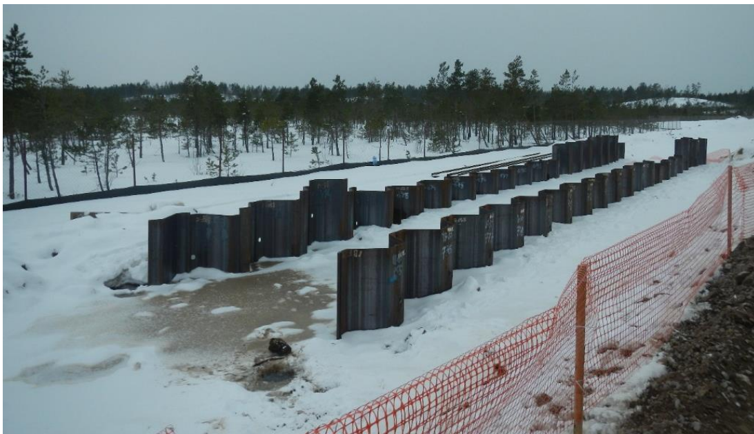
Рисунок 5.5 – Шпунтовая стенка (январь 2019 г.)
