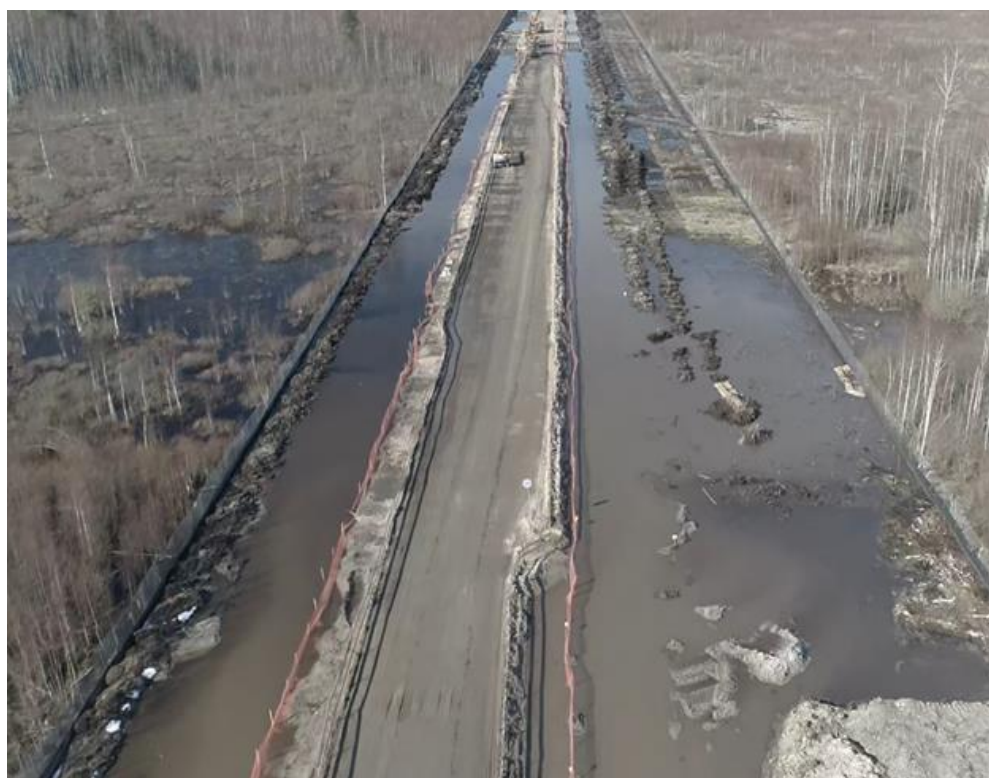
Рисунок 5.4 – Вырытые траншеи для двух ниток газопровода (март 2019 г.)
