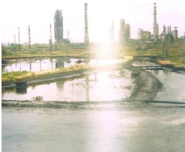
Рис. 1.16. Механические очистные сооружения г. Грозный, площадка №3-4
