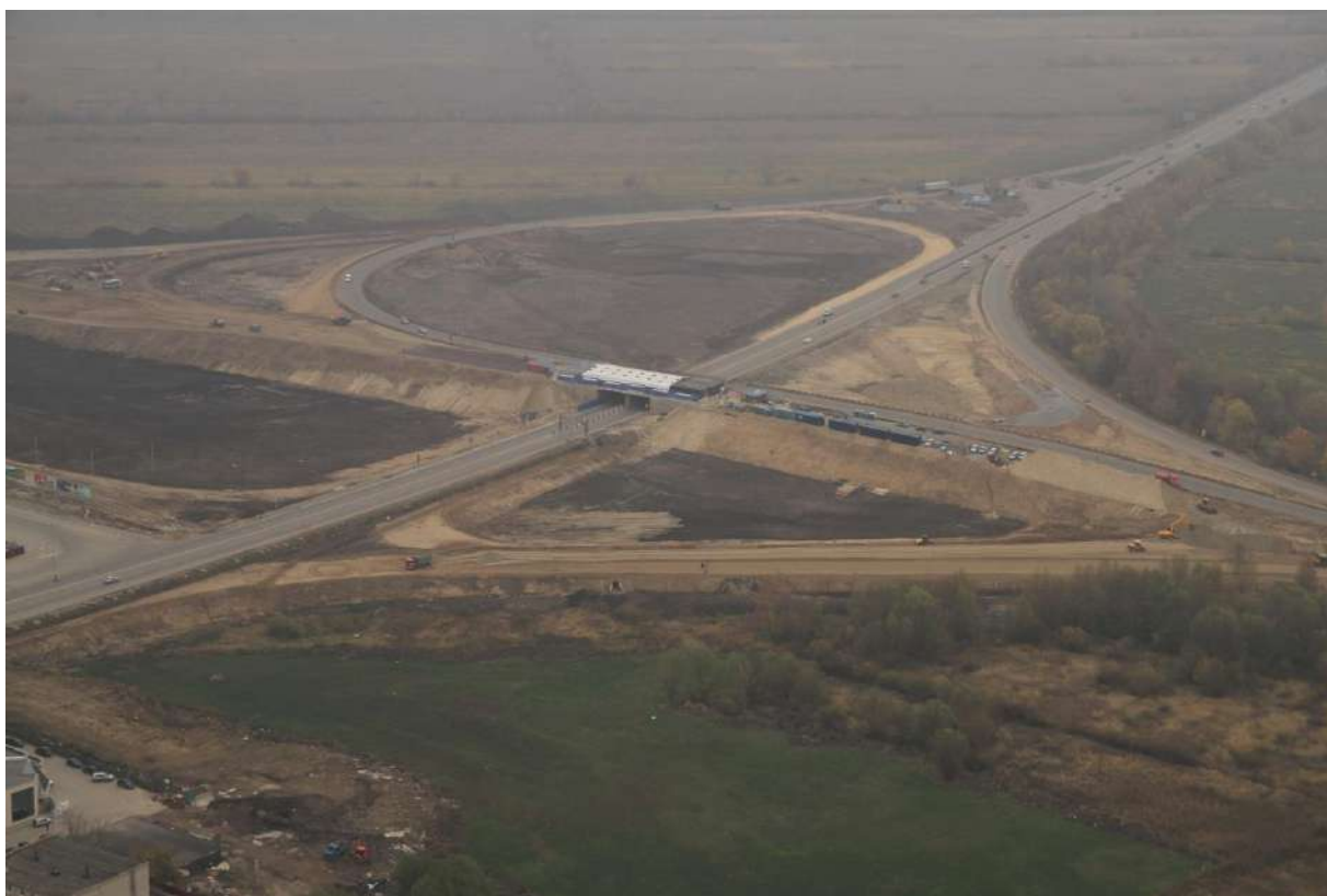
Рис. 69. Строительство автомобильной развязки у г. Рязань. Морфоскульптура насыпей дорог высотой до 10 м.
