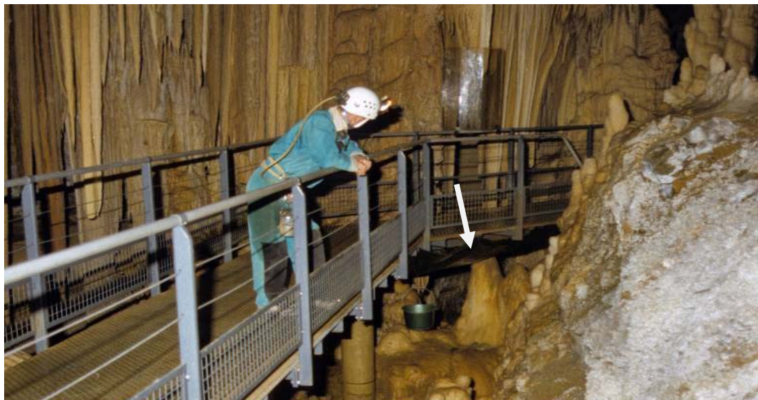
Поднятая дорожка в экскурсионной пещере Гуфр д'Эспаррос (Gouffre d'Esparros), Франция. Стрелка указывает, что сетка используется для дополнительной защиты и предотвращения падения отложений на натёк внизу. Фото: John Gunn.
