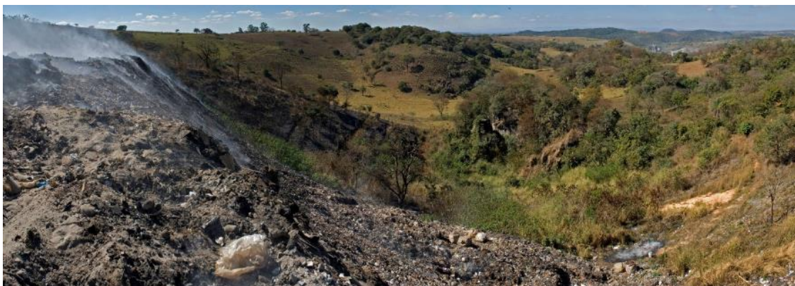
Свалка бытовых отходов в карсте, устроенная с нарушениями, Лагоа Санта (Lagoa Santa), Бразилия. Фото: Luciana Alt.
