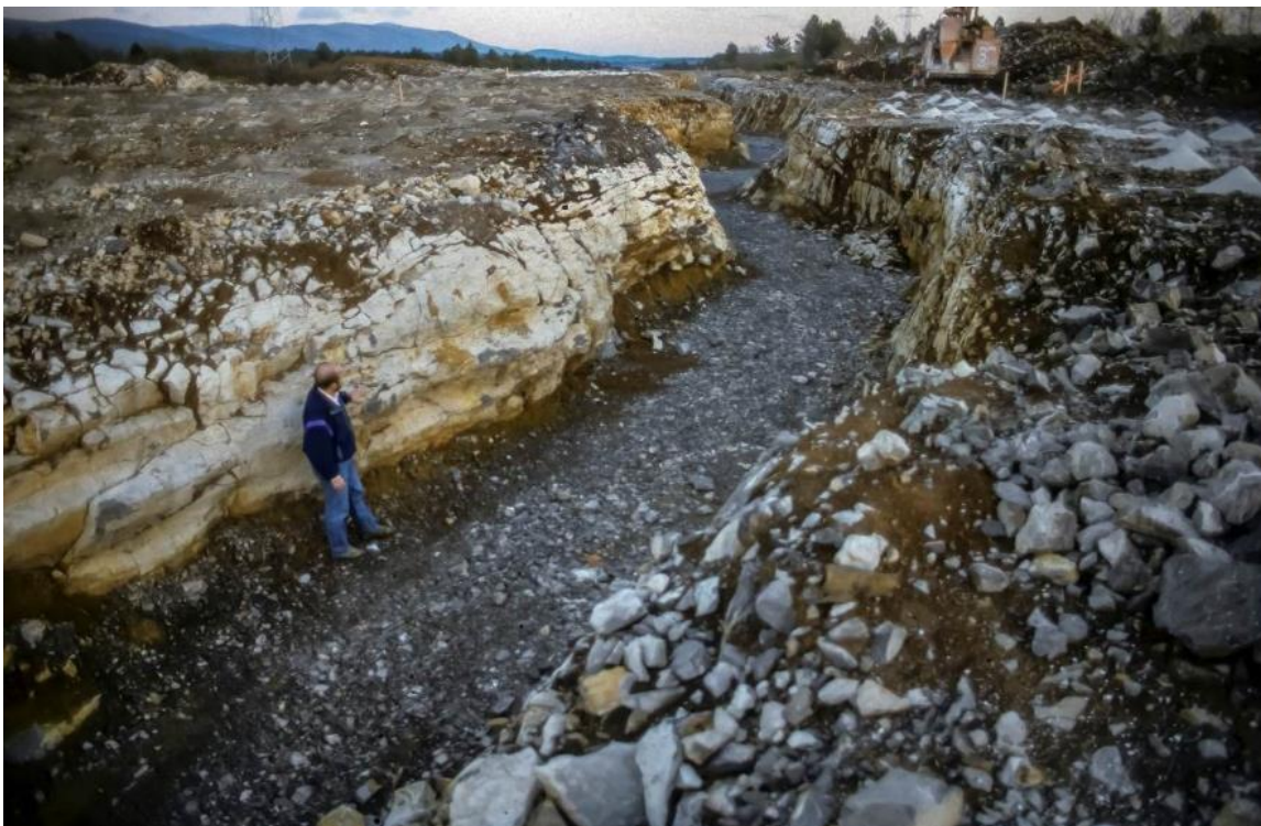
Маршрут той же самой автострады в Словении проходит над объектом, который изначально был вскрытой пещерой, заполненной отложениями. Сотрудничество между строителями и Карстовым институтом в Постойне обеспечило тщательное обследование пещеры перед её заполнением обломками пород и герметизацией для уменьшения риска обрушения. Фото: John Gunn.
