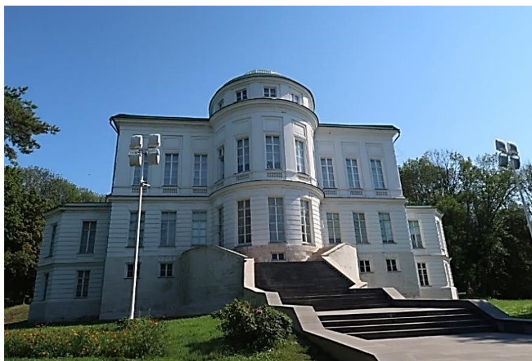
Рис. 11. Усадебный дворец в Богородицке, западный фасад. Фото Т.А. Галкиной, 2022. Fig. 11. Manor Palace in Bogoroditsk, western facade. Photo by T.A. Galkina, 2022.
