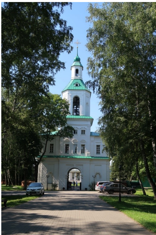
Рис. 13. Въездная башня-колокольня. Фото Т.А. Галкиной, 2022. Fig. 13. Entrance tower-bell tower. Photo by T.A. Galkina, 2022.
